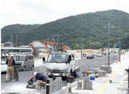
市内工事の様子
